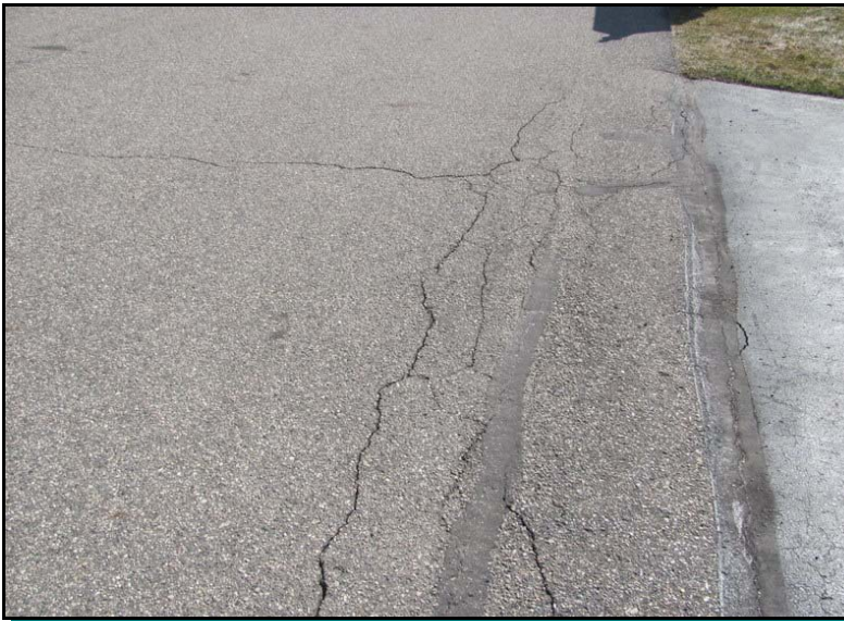
Edge cracks
